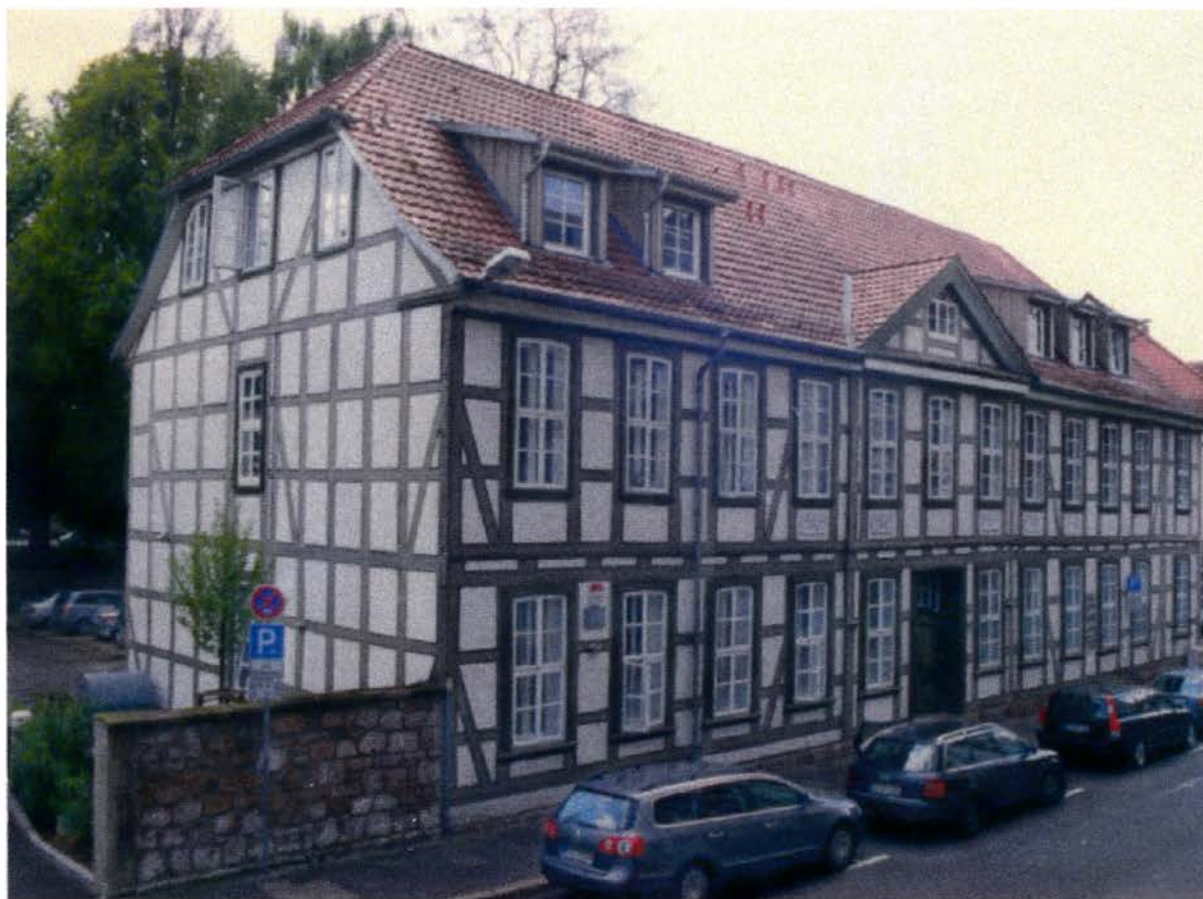
Abb.1. Das chemische Laboratorium in der Hospitalstraße 10 (alte Hausnummer) bzw. Nr. 7 (neue Hausnummer) im Jahr 2008 mit den auf dem Dach neu eingesetzten Schleppgauben.
