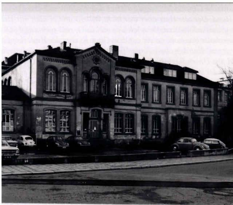
Abb. 8: Hospitalstr. 9. Die fünf Fenster des Windaus-Saals (Doktorandensaal) befinden sich rechts an der Gebäudeecke des westlichen Flügels im ersten Obergeschoß.
