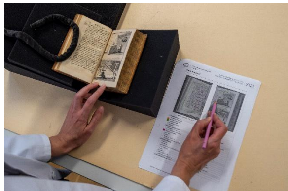
Bild 5: Sichern eines Risses in einer Falttafel mit Japanpapier und Weizenstärkekleister.
